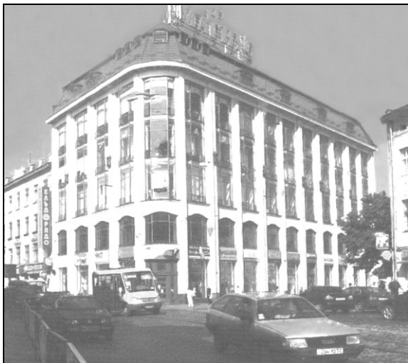
Uniwersalny Dom Towarowy. W latach 20. i na pocz. 30. XX wieku Małopolski Zakład Odzieży, Lwów, fot. Adam Zaleski
